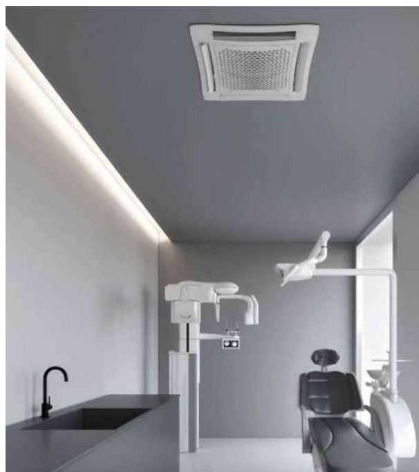
Instalación SKYSAFE en falso techo.
