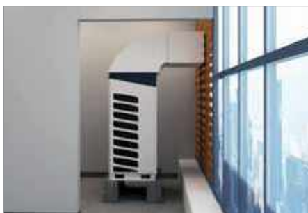
Instalación del conducto
